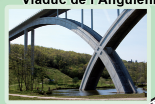
Viaduc de l'Anguienne
