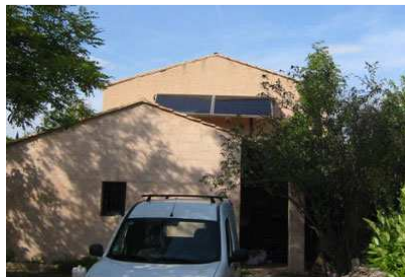
En garde corps au-dessus d'un pan de toit
