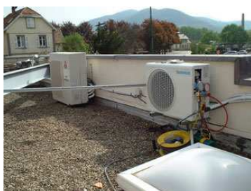
Sur le toit derrière un mur acrotère
