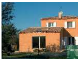
Intégré à la toiture de l'extension
