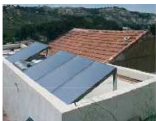
Derrière un mur acrotère en toiture
