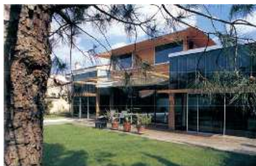
Elément de composition de la façade
