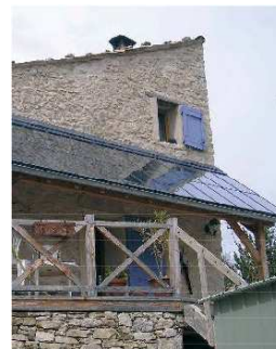
En couverture d'une pergola
