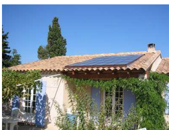
Sur l'arrière du bâti
